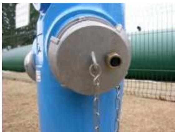
**Poteau d'aspiration de 150 mm muni d'un Airclap**
