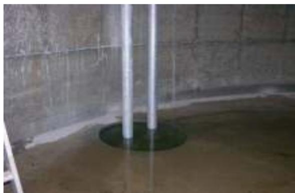
**Fond de la cuve avec crépine sous le niveau le plus bas de l'eau**
