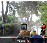
TRAVAUX Travaux de restriction de circulation et stationnement
