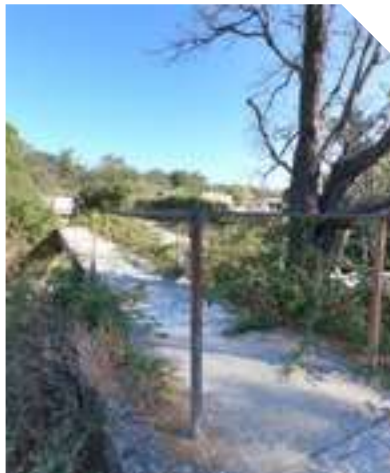
La Passerelle des Gorgues avant restauration
