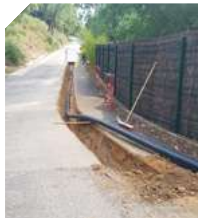
Renforcement du réseau d'eau potable à Guerrevielle
