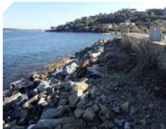
Enrochement protégeant le cimetière de Saint-Tropez
