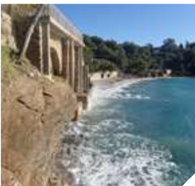
Escalier du Bailly de Suffren
