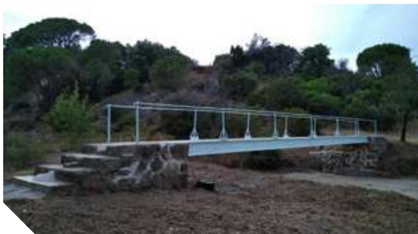
La Passerelle des Gorgues après restauration
