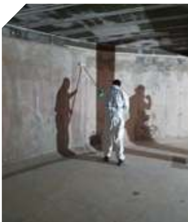
Réhabilitation du réservoir de Thalassa
