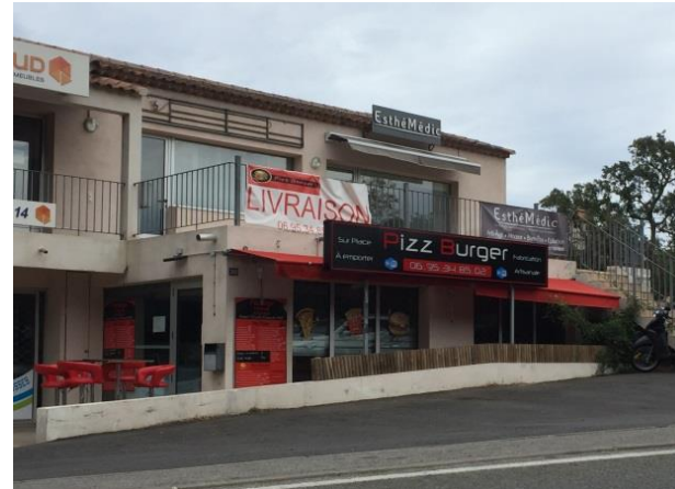
Enseigne murale visible depuis la RD559 - Non-conforme à la réglementation nationale - Dépasse les limites du mur de la façade (Esthémédic) et saillie trop importante (supérieure à 25 centimètres) pour Pizz Burger.
