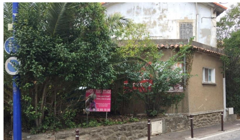
Préenseigne murale – actuellement interdite donc non conforme. Pourra être autorisé jusqu'à 4m 2 si réintroduction dans le RLP.
