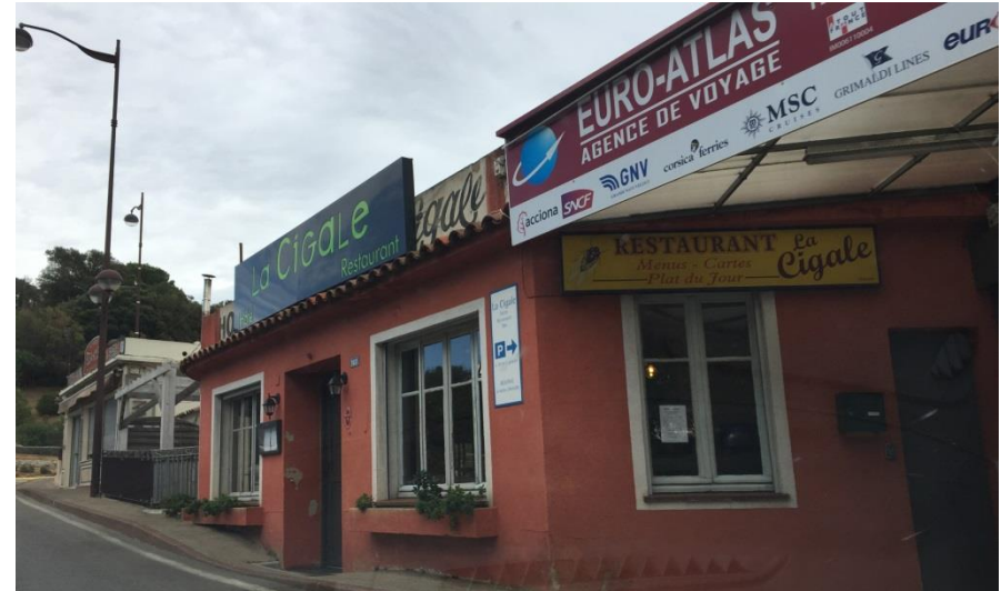
Enseigne sur toiture (La cigale) – Non conforme à la RNP, les lettres doivent être découpées et sans fixations visibles
